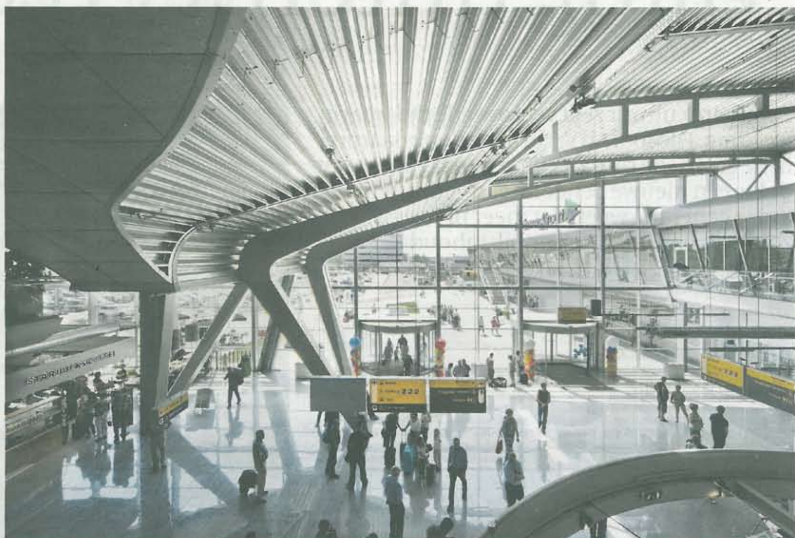
De vernieuwde vertrekhal van Eindhoven Airport, die in juni is opgeleverd. Onder: het exterieur van de luchthaven.
