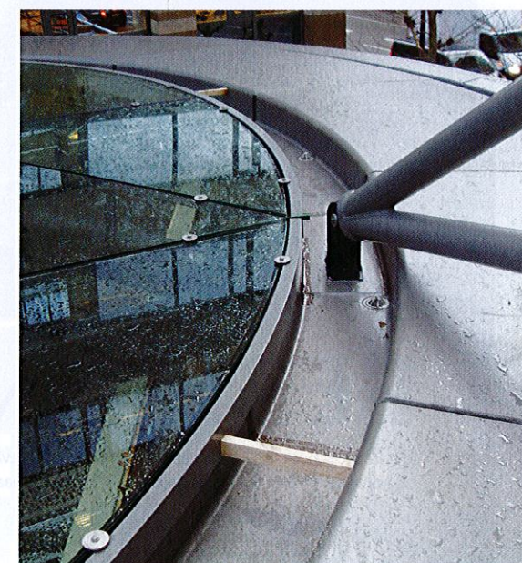
De luifel heeft twee ringgoten. In de bovenste zijn de drie ankerpunten voor de ophanging aangebracht.
