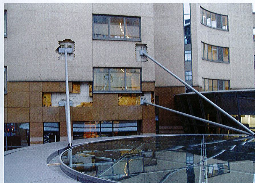
Voor de verankering van de ophanging aan de draagconstructie van de belendende kantoren zijn de gevels plaatselijk opengemaakt en later weer aangeheeld.
