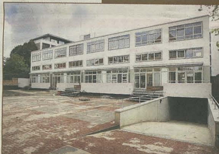
De witte stadswoningen aan de achterzijde.
