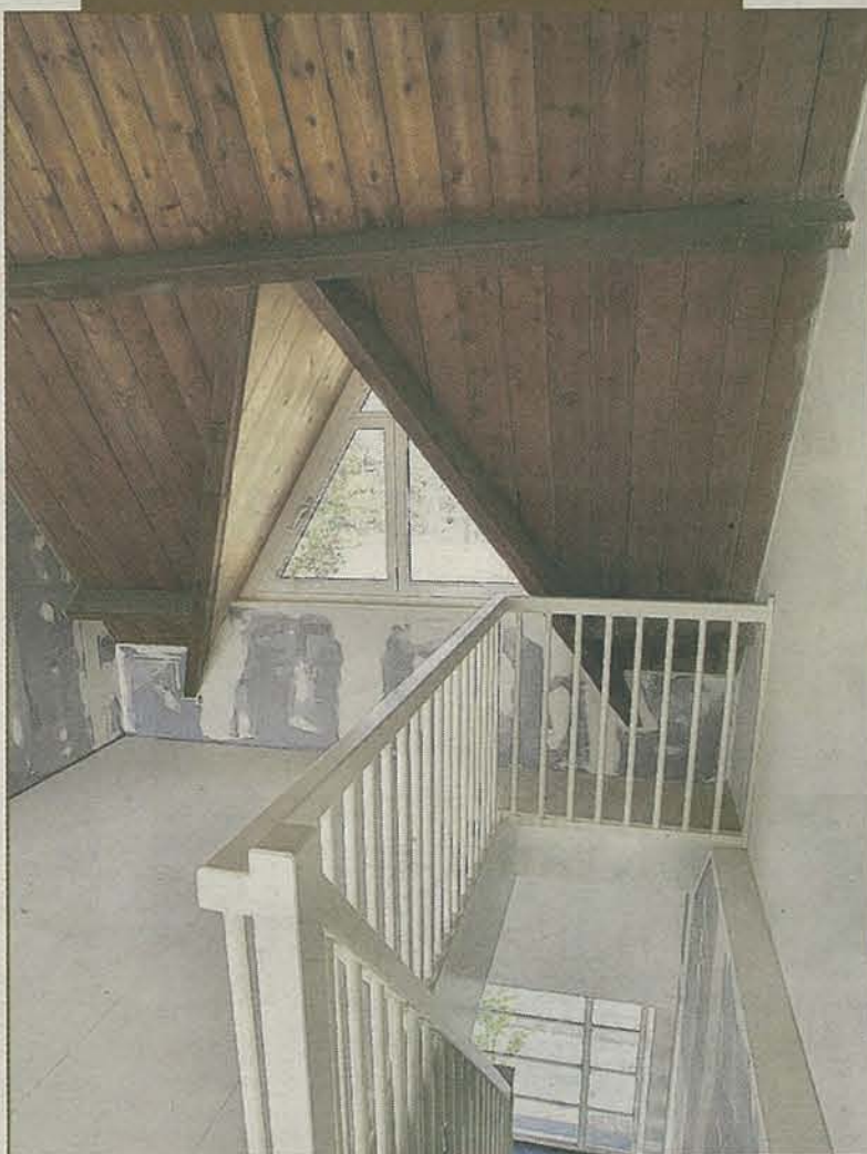
Een van de nieuwe dakkapellen.
